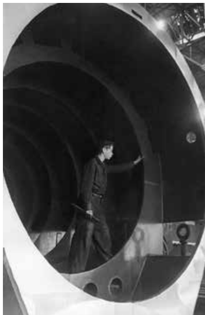
Статор турбогенератора мощностью 50 тысяч киловатт для восстановления разрушенной фашистами Сталиногорской ГРЭС на сборочном стенде завода «Электросила» им. С. М. Кирова. 21 августа 1944 г.
