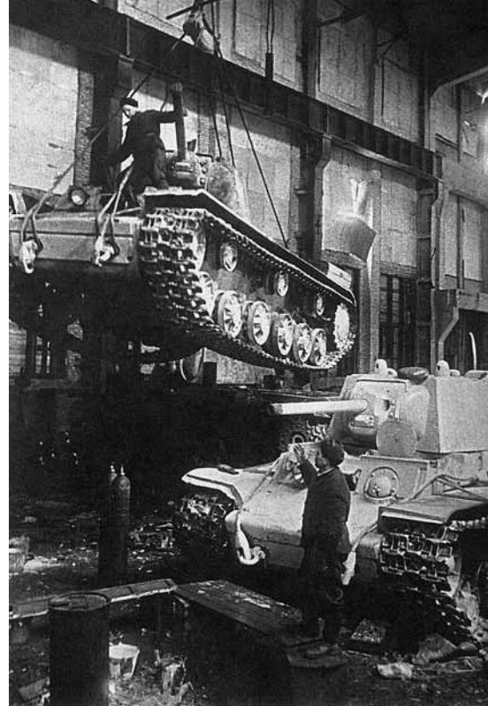
Ремонт танков КВ в цехе №19, 1943 г.
