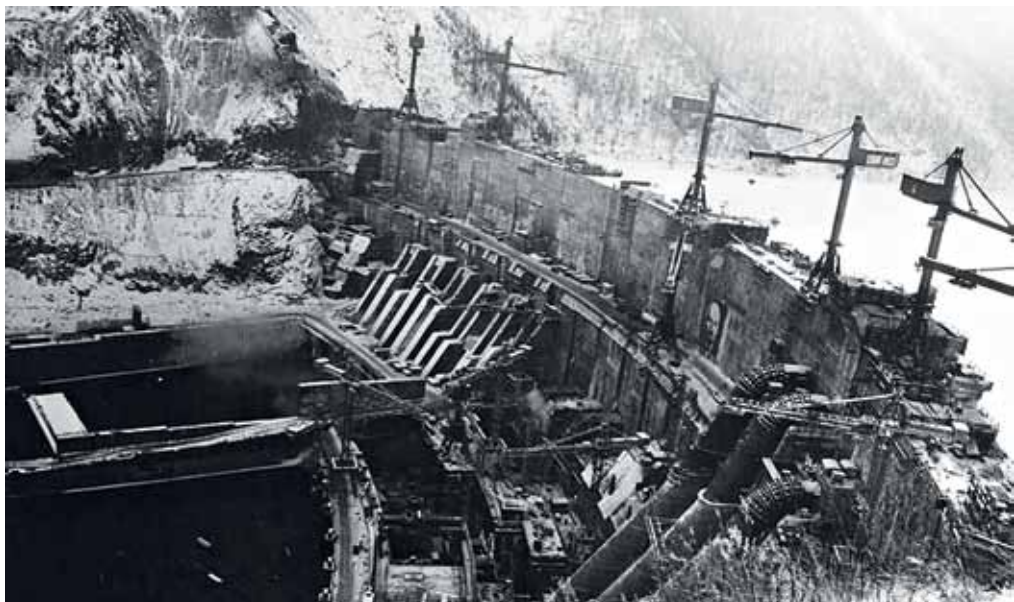
Строительство Саяно-Шушенской ГЭС
