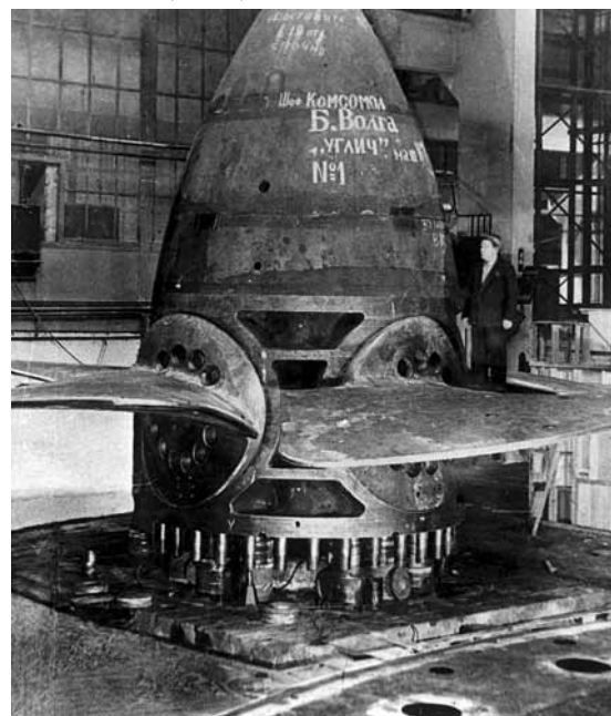
Поворотно-лопастная гидравлическая турбина мощностью 55 МВт для Угличской ГЭС, 1939 г.
